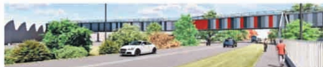
In 5,50 Meter Höhe überwindet eine Elektrobahn künftig die Großostheimer Straße und transportiert Material vom neuen Logistikzentrum auf dem ehemaligen Joyson-Gelände in die Produktionshallen des Staplerbauers.
